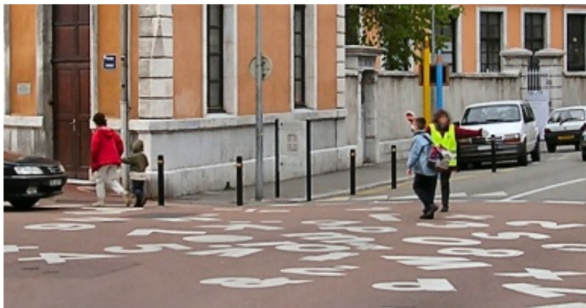
Sortie d'école aménagée en plateau surélevé à Chambéry
